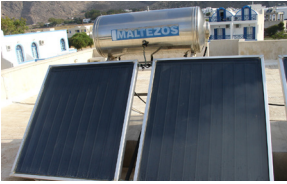
Güneş kolektörleri güneş enerjisini kullanarak sistemdeki suyun ısınmasını sağlar.
